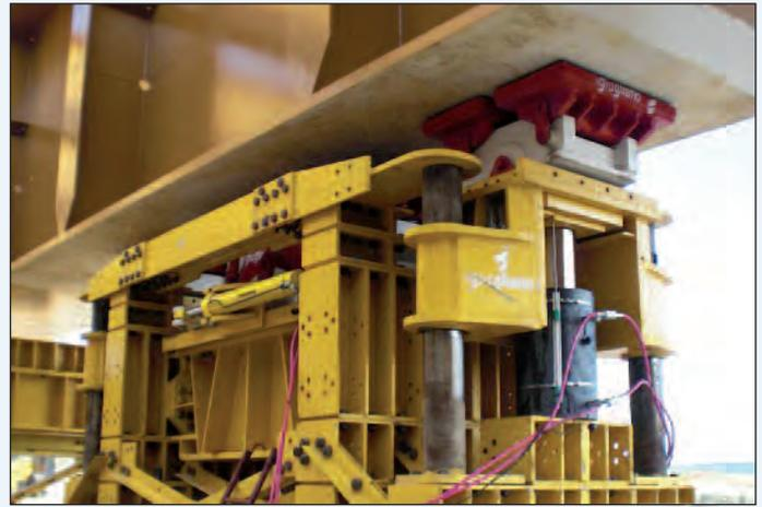
Figura 15 - I martinetti di sollevamento e il trasduttore si spostano in verticale (di livello)
