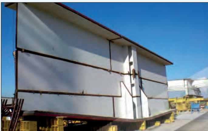
Figura 5 - L'assemblaggio in cantiere e controllo della verticalità degli elementi di concio
