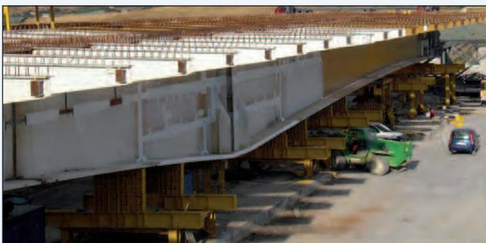
Figura 6 - La sequenza di assemblaggio in cantiere degli elementi di concio
