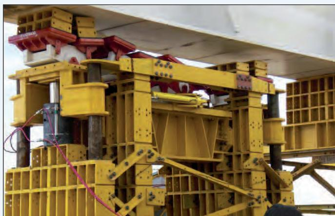
Figura 10 - Il sistema di varo ideato con rappresentazione dei martinetti di sollevamento per il viadotto
