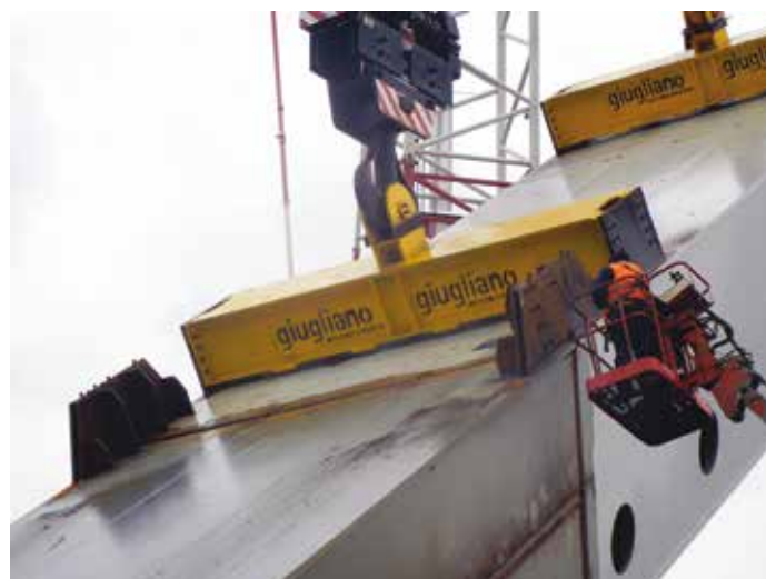
10. L'allineamento progressivo di un concio dell'arco
