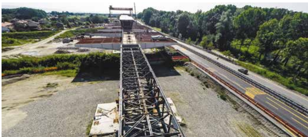
9. Vista dell'avambecco per il varo del ponte
