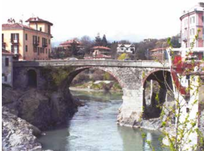
3. Vista da valle del vecchio ponte di Ivrea
