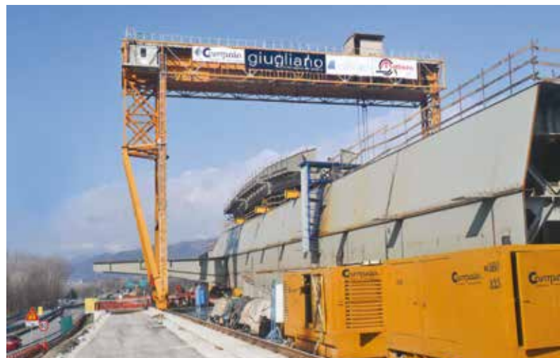
12. La gru a cavalletta per assemblaggio ponte
