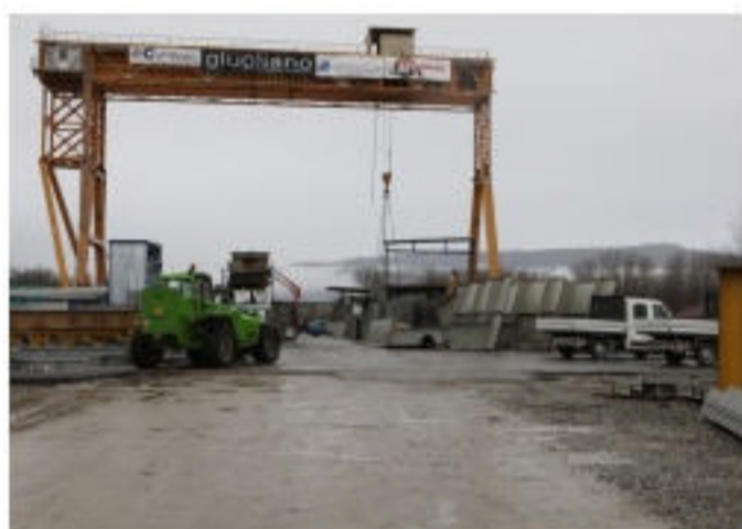
Il cantiere all'opera da tre anni
